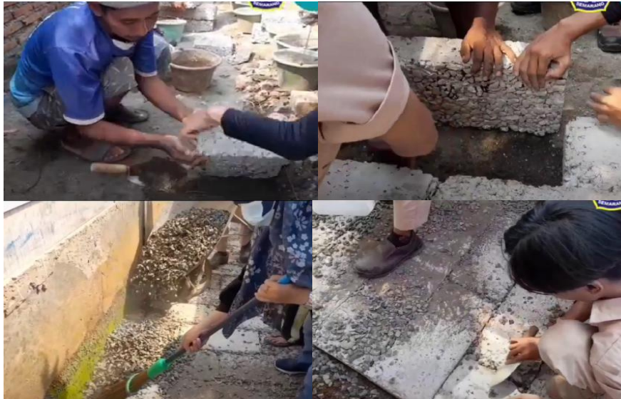
Gambar 2. Pemasangan blok beton porous
