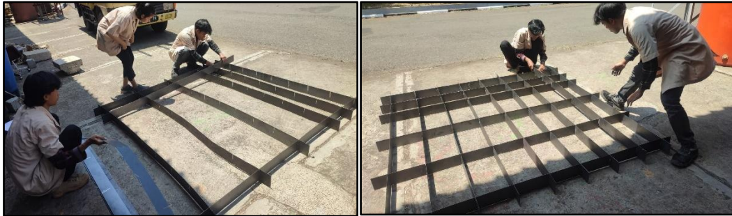
Gambar 1.6. Pembuatan cetakan beton porous
