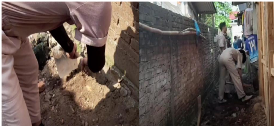
Gambar 1.9. Pembersihan lahan yang akan dipasang blok beton porous
