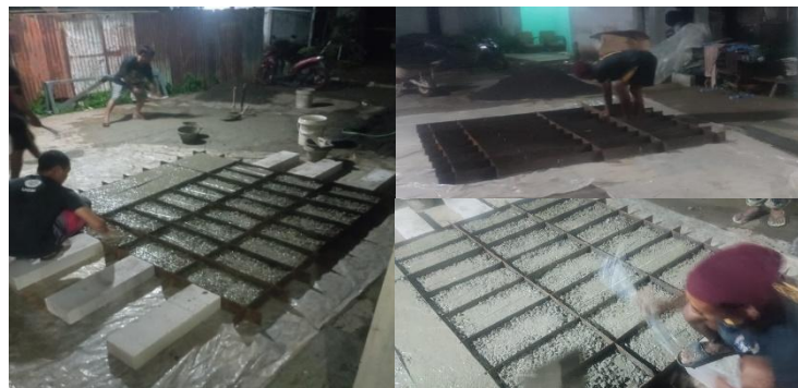
Gambar 1.7. Pembuatan blok beton porous
