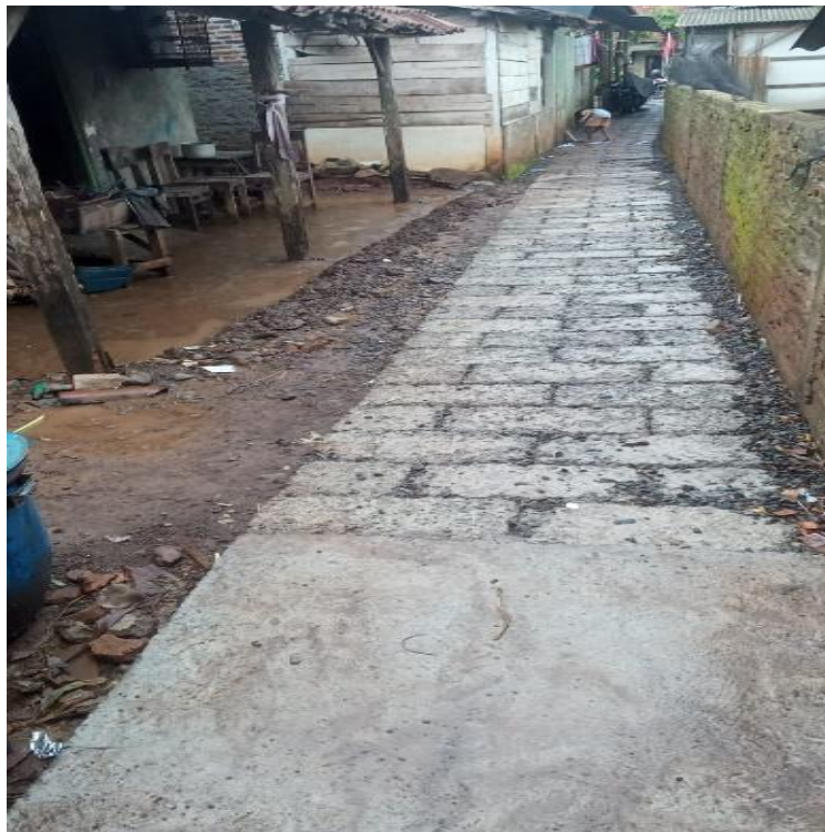
Gambar 2.1 Pemasangan blok beton porous
