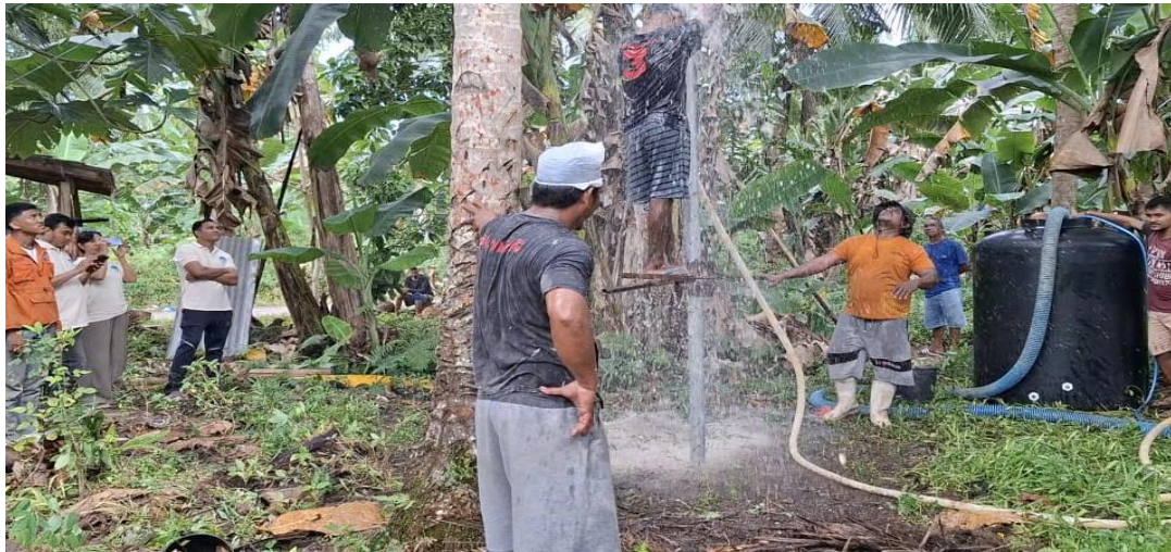
Gambar 11. Proses pengeboran sumur untuk memperoleh sumber air tanah sesuai hasil
