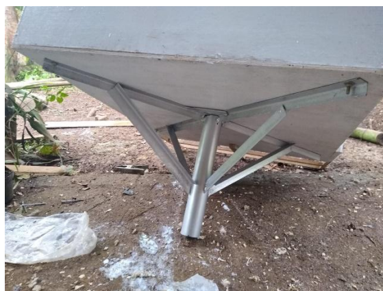
Gambar 4. Pemasangan besi siku sebagai penghubung dari tiang dan rumah burung hantu.
